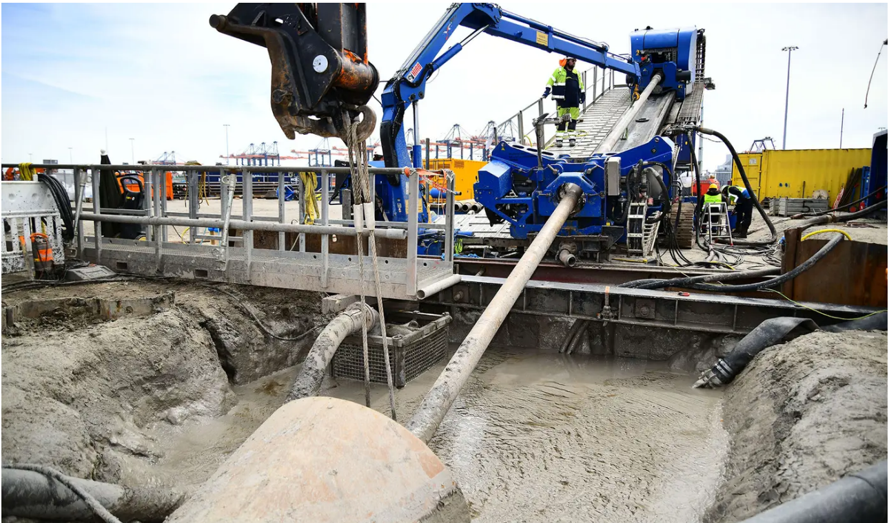
Een gigantische boor boort door de zeewering van Rotterdam ter voorbereiding op de nieuwe Porthos CO2-pijpleiding. © PorthosCO2
