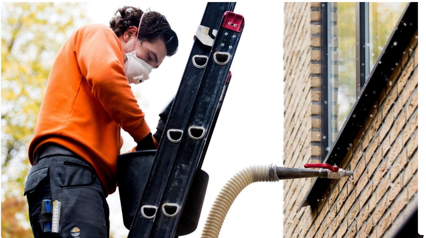
Het isoleren van een huis
