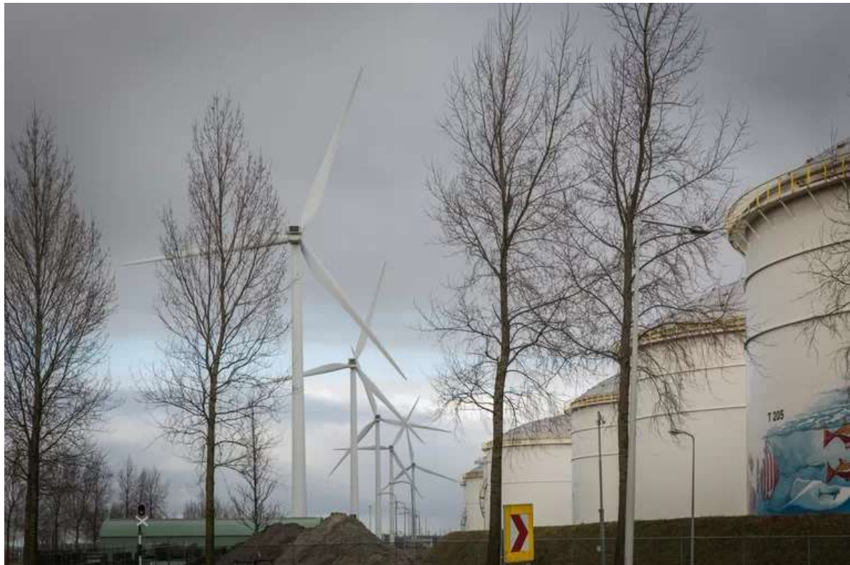
Windmolenpark Ruigoord aan de Westpoortweg in het Westelijk Havengebied. BEELD DINGENA MOL
